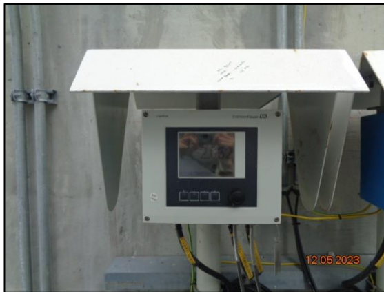
เครื่องมือวัดความเป็นกรดด่าง (pH) และอุณหภูมิ (Temperature)
