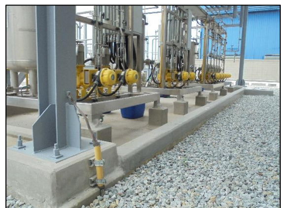
รูปที่ 2-36 คันกันป้องกันสารเคมีหกรั่วไหล (Dike)
